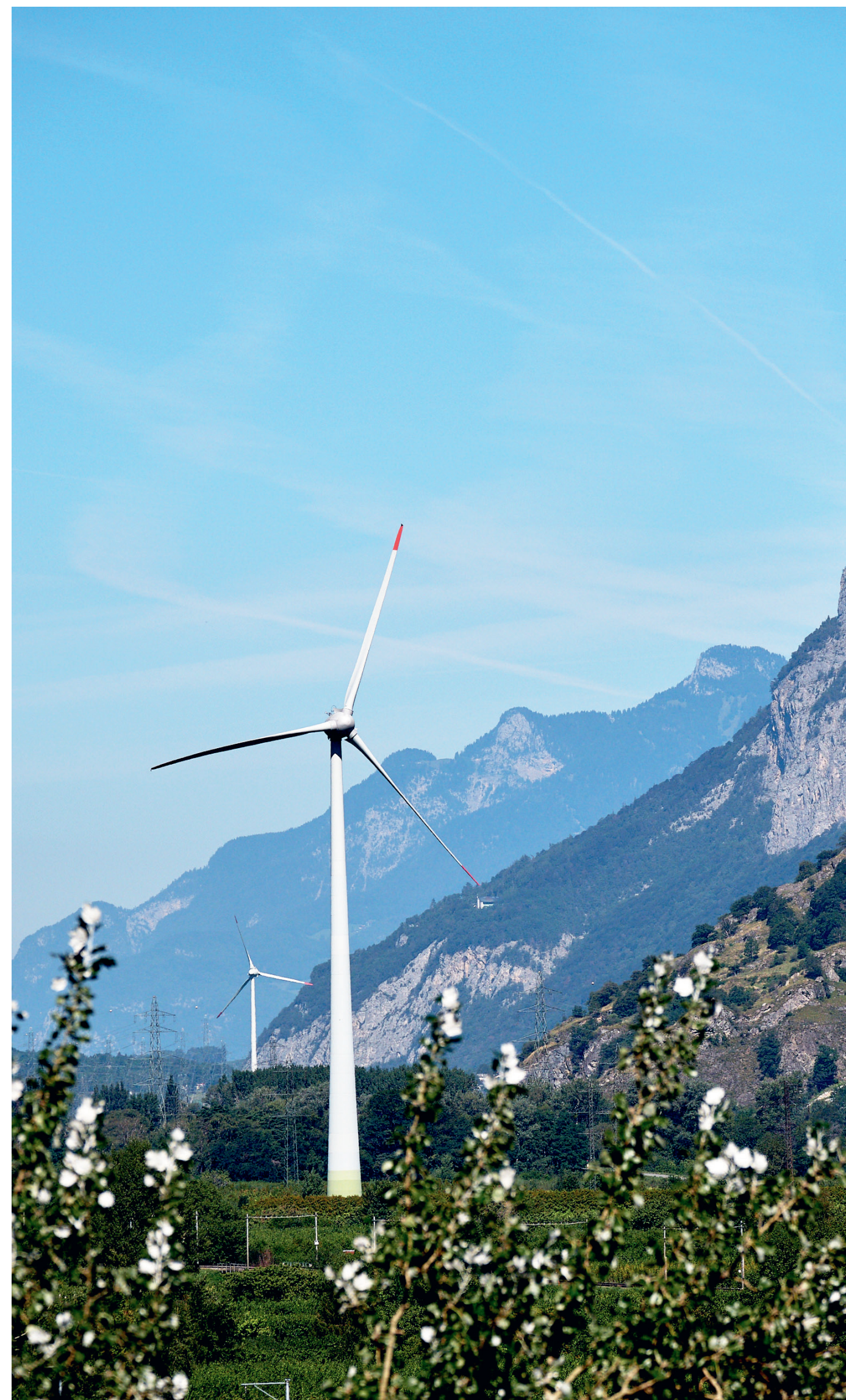
Les éoliennes de Collonges et Martigny dans la Vallée du Rhône.
